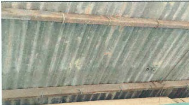
Foto 2: Se observa la estructura portante del modulo 1.
